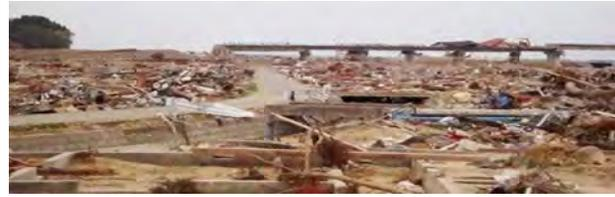
この写真は、高架の線路が、途中で破壊されています。よく見ると線路の上に民家の屋根が、漂着しています。
